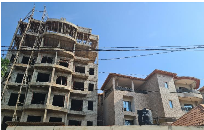
Abbildung 4: Gebaut wird mit Gerüsten aus Holz
